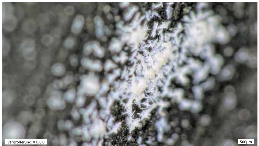
»8 Detail of a roof tile surface with efflorescences, shown without a depth sharpening correction at a tilt angle of 15° from the z-axis »8 Detail einer Dachziegeloberfläche mit Ausblühungen ohne Tiefenschärfen-Korrektur bei einem Kippwinkel der z-Achse von 15°
