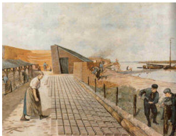
Bild 11: Ansicht einer handwerklich regionalen Ziegelfertigung
